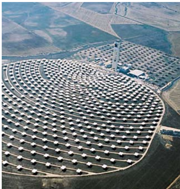
Figura B.8 - Impianto a ricevitore centrale
